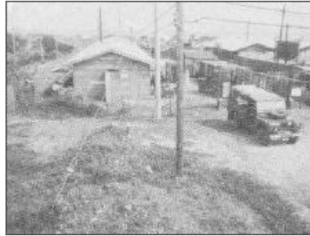
Above, the Troop position at Vung Tau.
